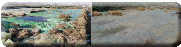
شکل ۴-۴. تجمع آب روی پوشش سیلو به دلیل عدم تنظیم سطح فوقانی سیلو
