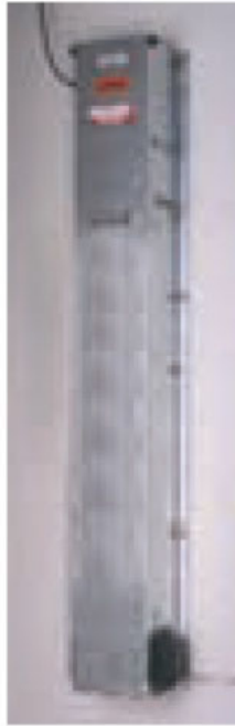
شکل ۲۶-۴. دماسنج کنترل کنند پمپ آب
