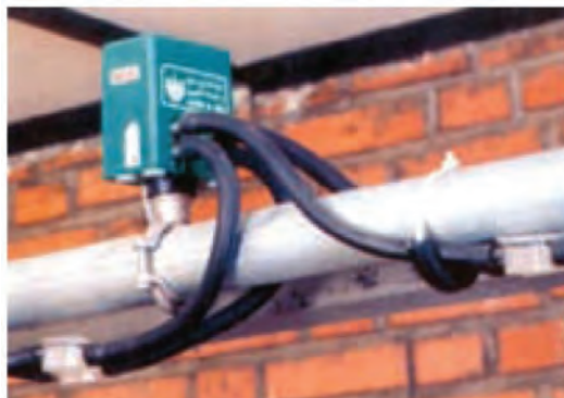
شکل ۴۰-۵. دستگاه نبض ساز
