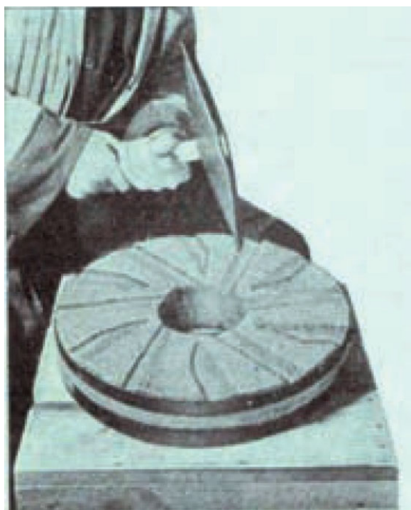
شکل ۳۹-۴- ایجاد شیار روی سنگ آسیا
