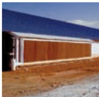
شکل ۲۴-۴- سیستم خنک کننده پوشال
