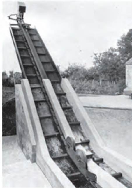
شکل ۳۰-۵. سطح شیب‌دار در انتهای مسیر نقاله
